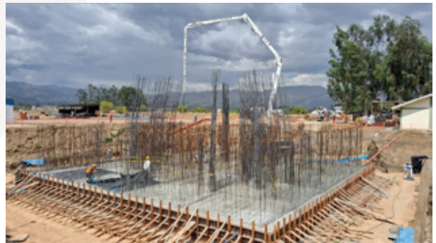
Avance de la obra: platea de cimentación.
