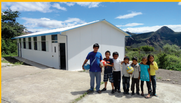
Niños y niñas de la IE de Mayobamba, provincia de Santa Cruz, junto al módulo instalado.
