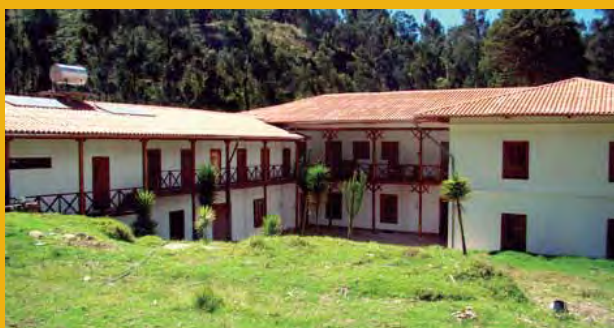
Instalaciones del Seminario San José luego de los trabajos realizados.
